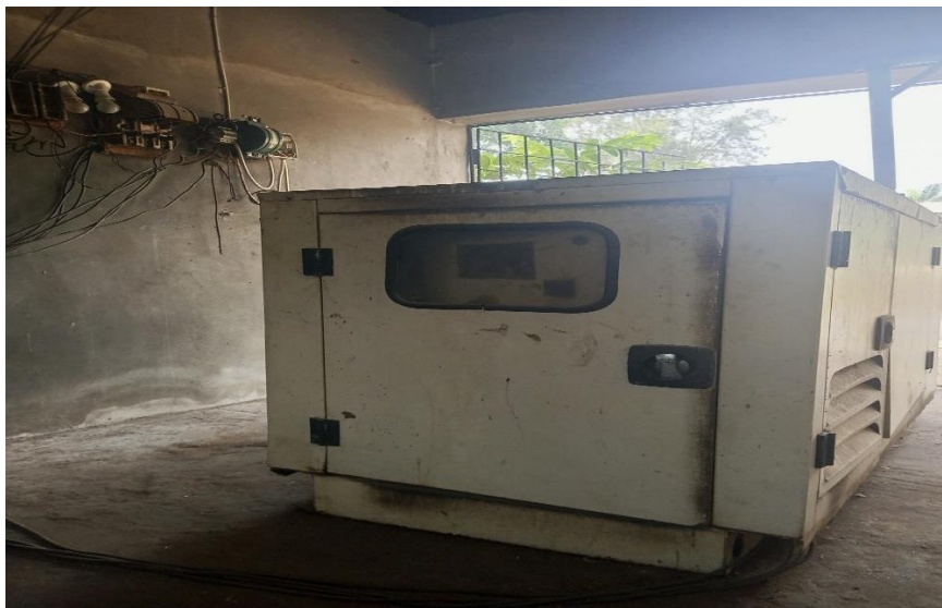
Vor dem Umbau : mit 30 KVA Generator:
